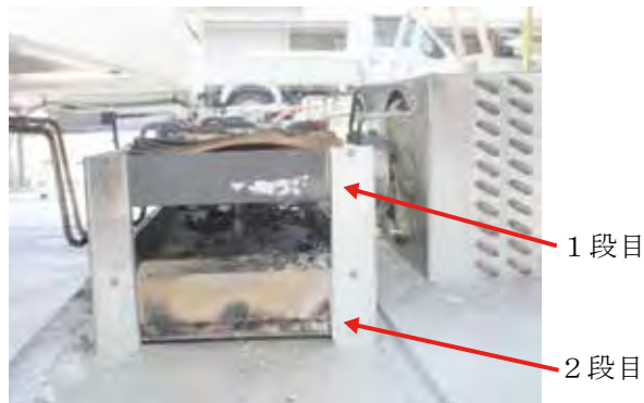
(写真9) 蒸発皿1段目及び2段目の状況
