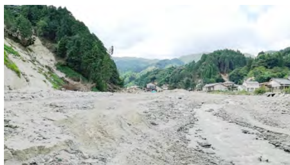
図 乙石川を下流から望む、谷全体が被災している
