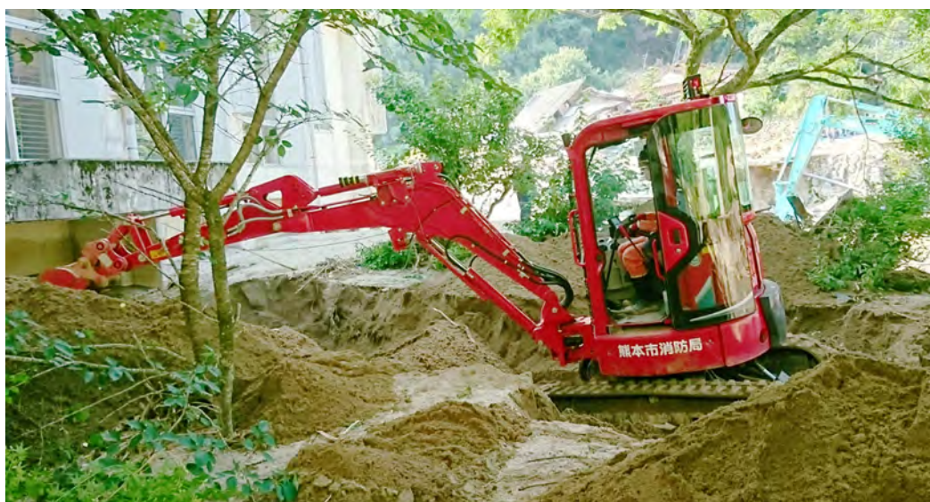
重機を活用した捜索・救助活動（提供：熊本市消防局）
