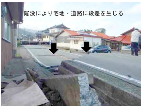
写真3(a) 陥没に伴い段差が発生した宅地と道路
