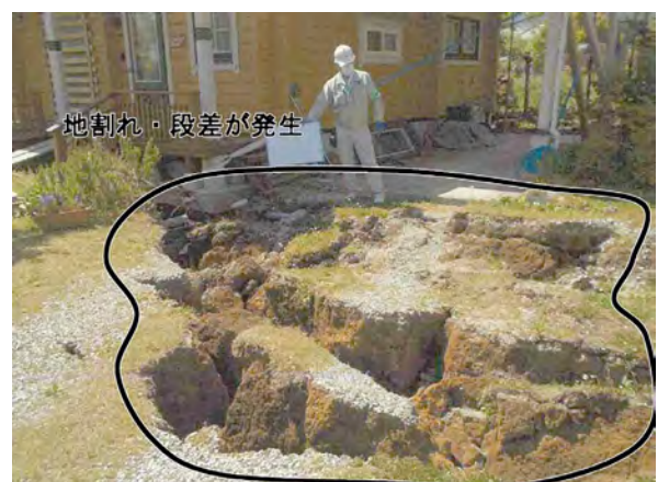
写真3(b) 大きな地割れ・段差が発生した宅地
