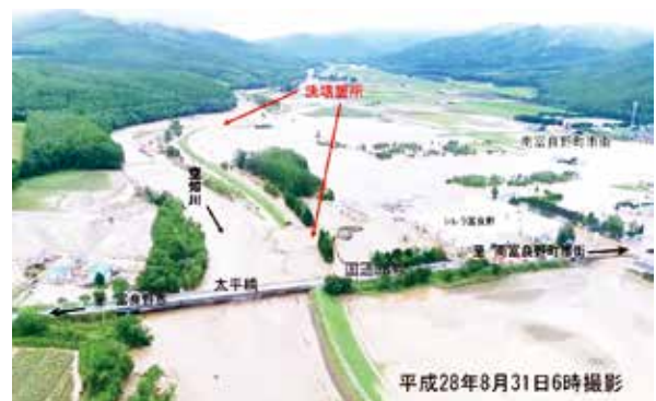
写真1 空知川の破堤（南富良野町）
