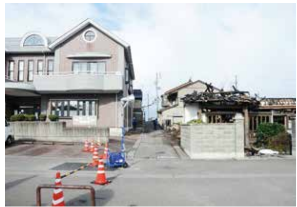
図3 耐火造建物での焼け止まり
