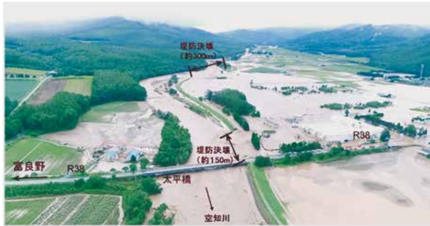
写真1 空知川の破堤後の氾濫状況（8月31日6:30撮影） （北海道開発局提供）
