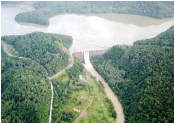
写真2 金山ダム貯水状況写真
