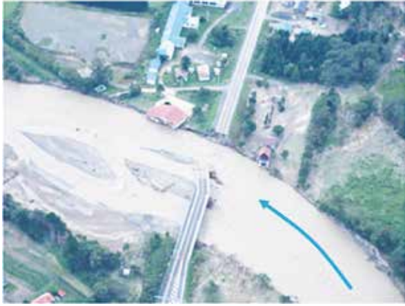
写真5 沙流川に架かる国道274号線・千呂露橋の落橋 (北海道開発局室蘭開発建設部提供)
