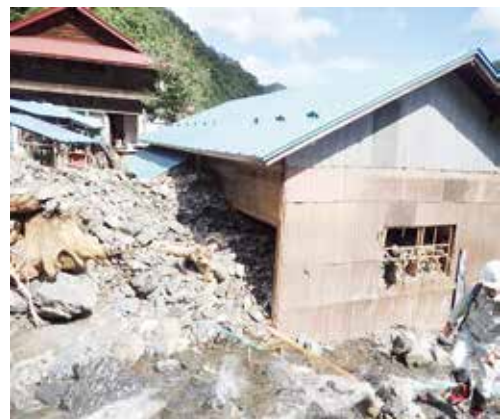
写真－3 岩泉町浅内下川代地区で発生した土石流が流れ込んだ作業小屋（平成28年9月9日撮影）
