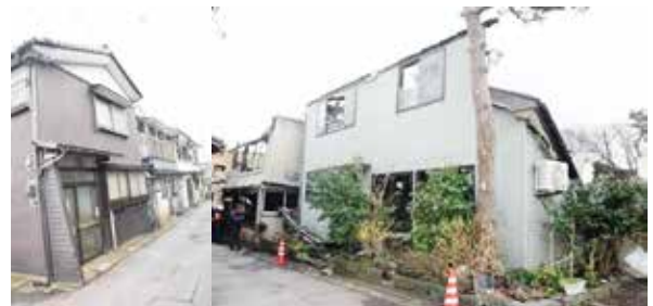
図8 路地を挟んだ木造住宅間でのやけ止まり
