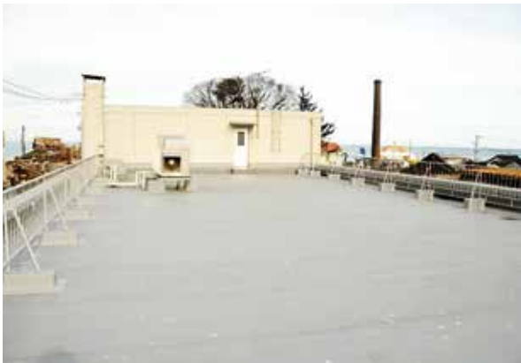
図6 火粉で損傷した防水層を修復した跡
