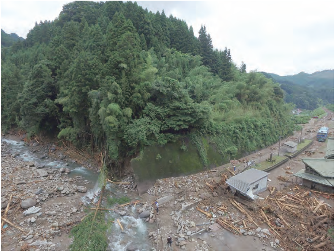
壊滅的被害を受けた岩屋駅付近 2017年7月8日撮影（写真提供：福岡県東峰村）
