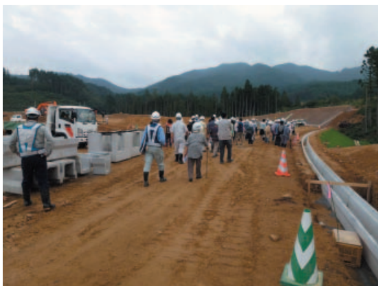
写真1 造成工事現場見学会の様子(2014年9月5日)
