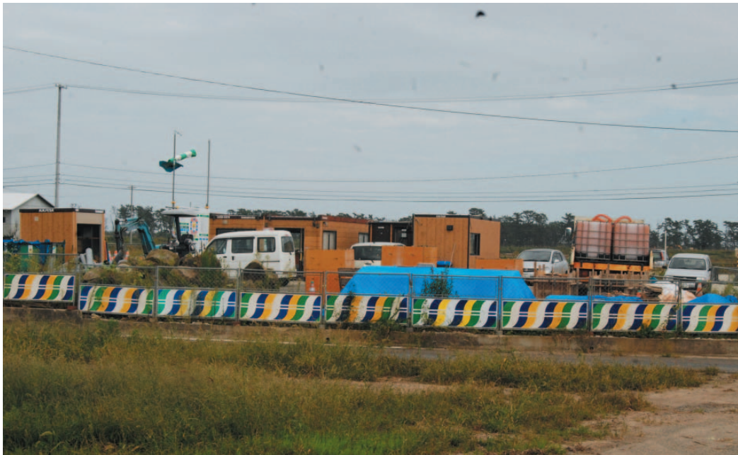
阿武隈川左岸復旧工事事務所 (2013年9月25日撮影)
