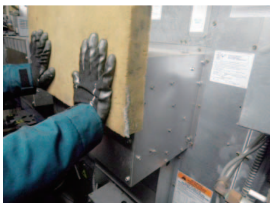
写真14 上のみ排気不良の再現
