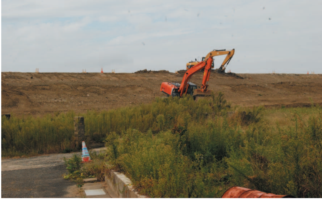
阿武隈川左岸堤防復旧工事の様子 (2013年9月25日撮影)
