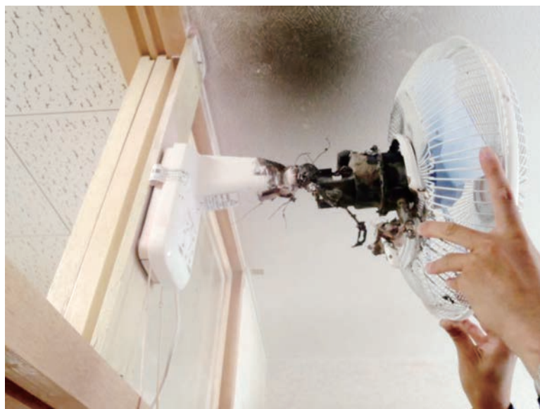
扇風機の焼損状況
