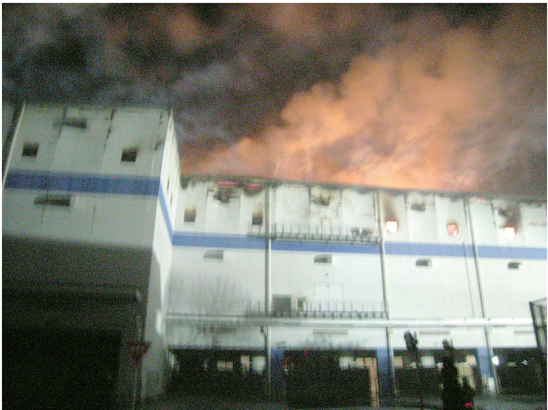
西面延焼状況（2017年2月19日撮影）
