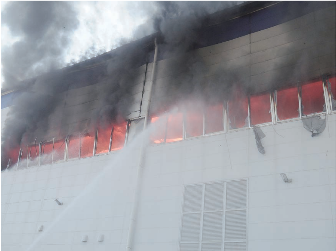
2階北側の燃焼状態（2017年2月16日撮影）
