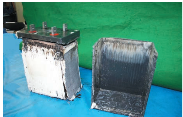
写真5 制御弁式措置鉛蓄電池の電槽側板を取り外した状況
