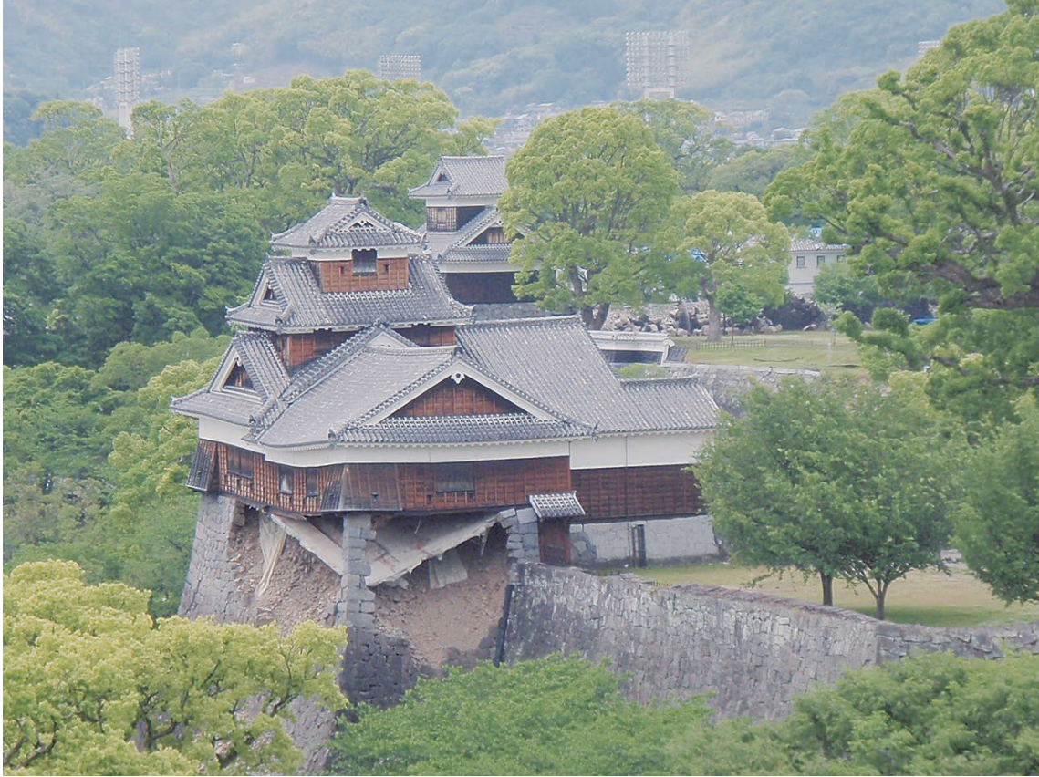
熊本城石垣崩壊の様子 2016年5月5日撮影（写真提供：熊本市消防局）
