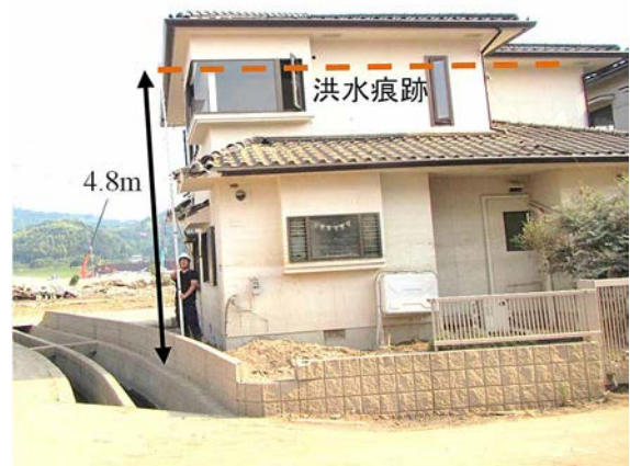
図-4 浸水深4.8mの状況
