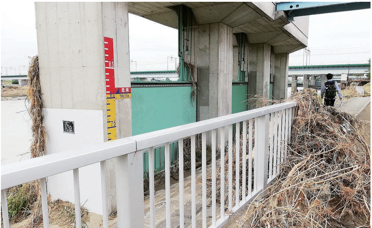
丸子橋付近の水門（東京都大田区） 撮影日：2019年10月21日（月）
