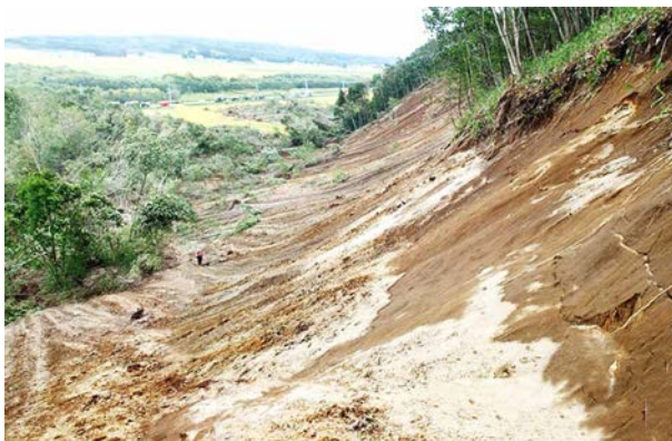
図3 吉野地区の崩壊の源頭部の状況
