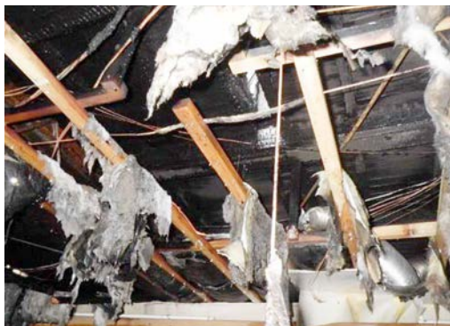
写真5 天井及び天井裏の状況
