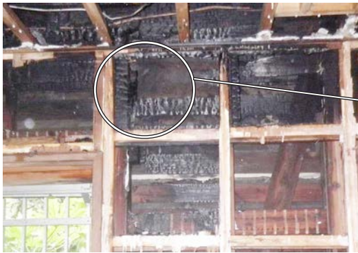
写真8 内壁を剥がした状況
