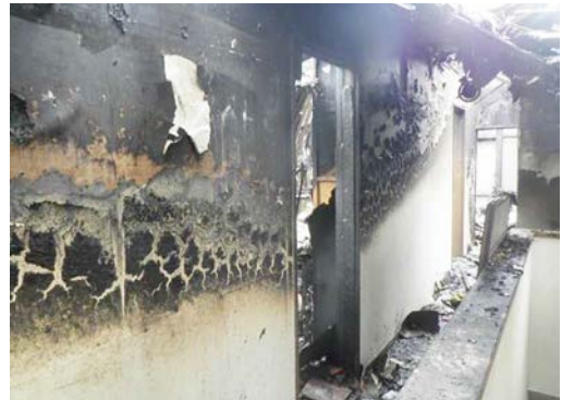
写真4 廊下部分の状況
