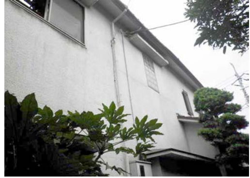
写真2 建物外周部（北西側）
