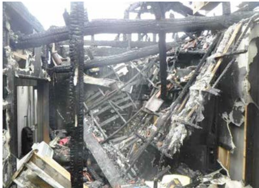
写真3 居室部分の状況
