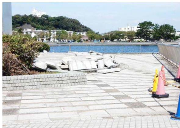
図-11 三笠公園でのコンクリート階段の飛散
