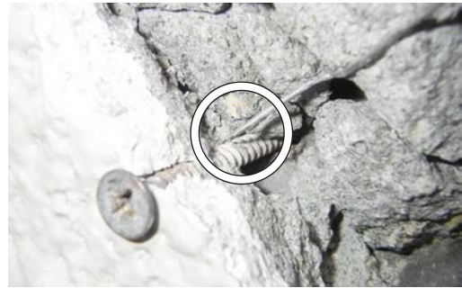
写真15 ネジとワイヤーラスの状況
