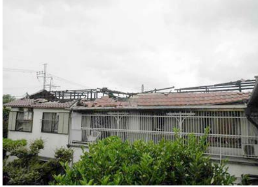
写真1 建物外周部（南東側）
