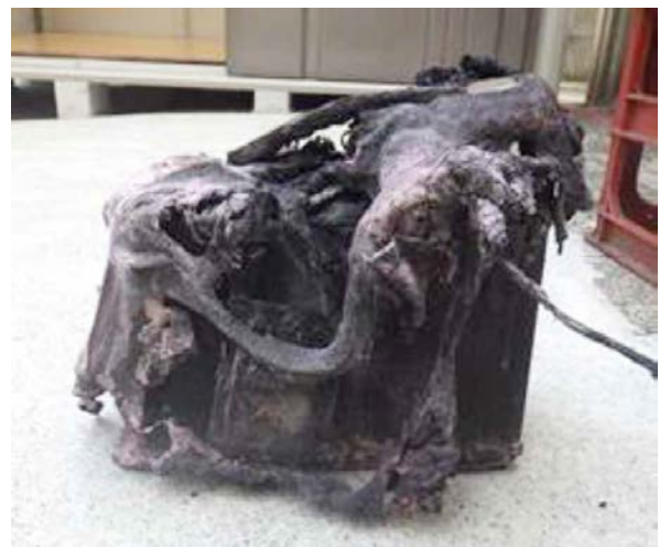
写真5 ポータブル電源前面の状況
