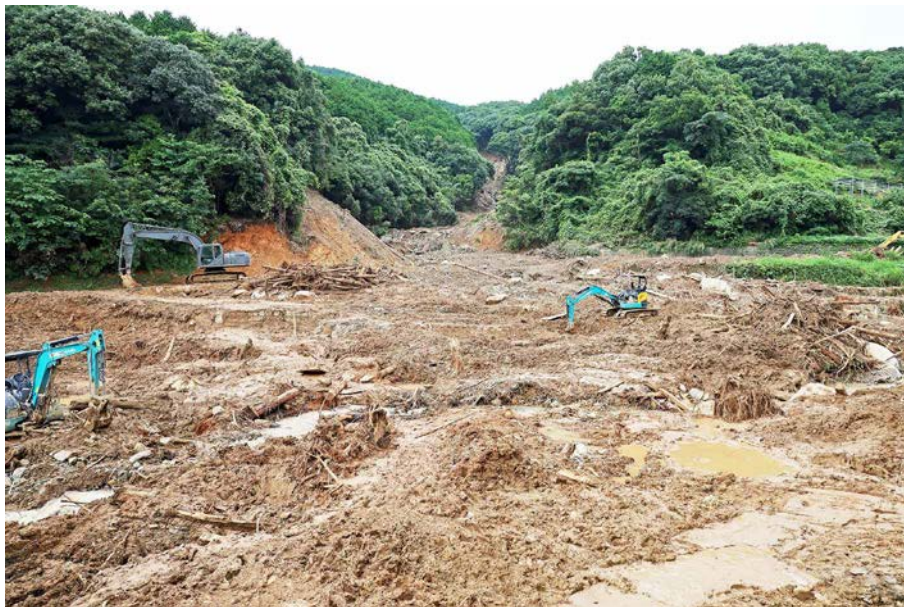
図9 津奈木町福浜地区の斜面崩壊に伴って発生した土石流の氾濫状況。
