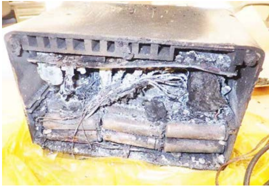
写真12 ポータブル電源上部の状況
