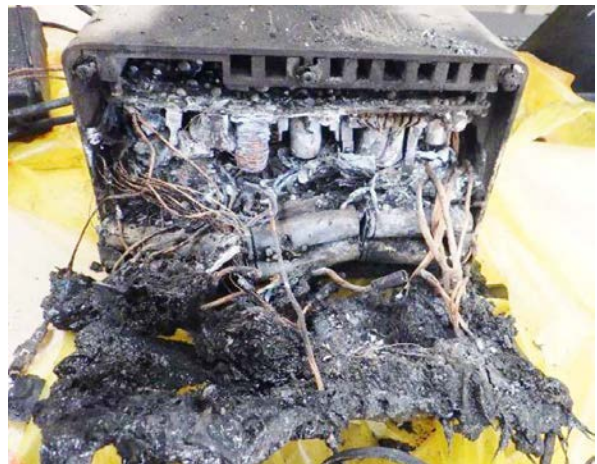
写真11 ポータブル電源上部の状況
