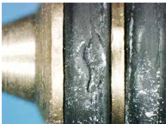
写真11 Oリングの損傷状況
