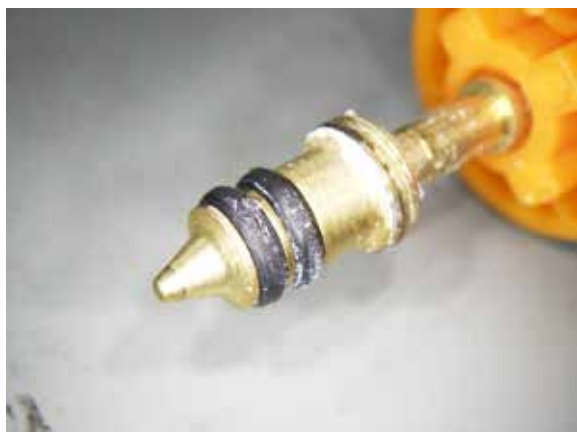
写真10 器具栓内部のOリング
