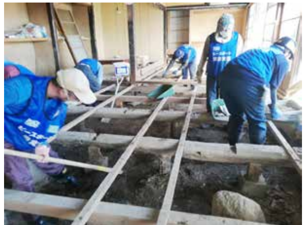
写真2 床下の清掃活動
