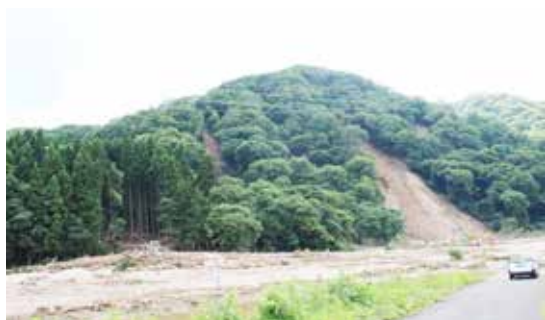
図2 関川村での斜面崩壊
