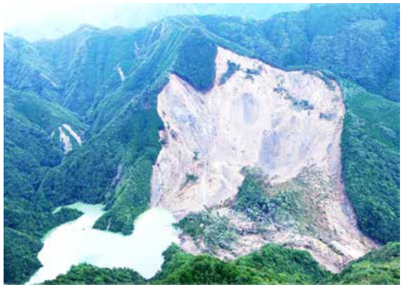
写真-5 2012年9月に台風12号により発生した深層崩壊と河道閉塞(天然ダム) 奈良県十津川村
