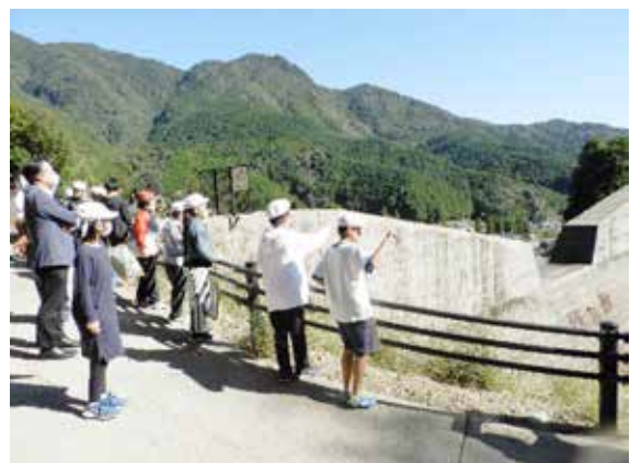
図10 砂防堰堤の見学
