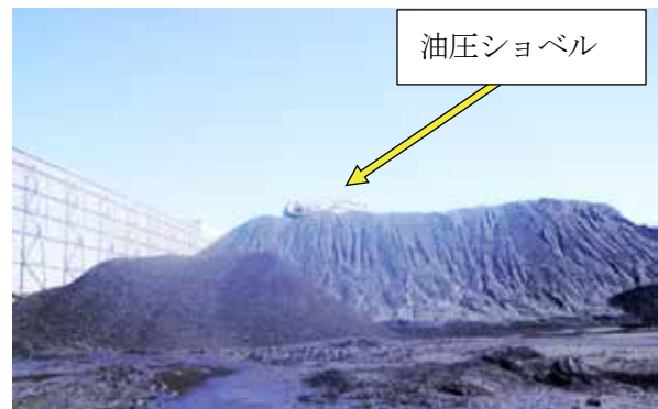
写真1：出火箇所周囲の状況
