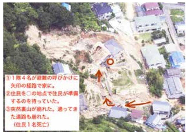
図9 土砂災害現場におけるヒヤリハットの事例
