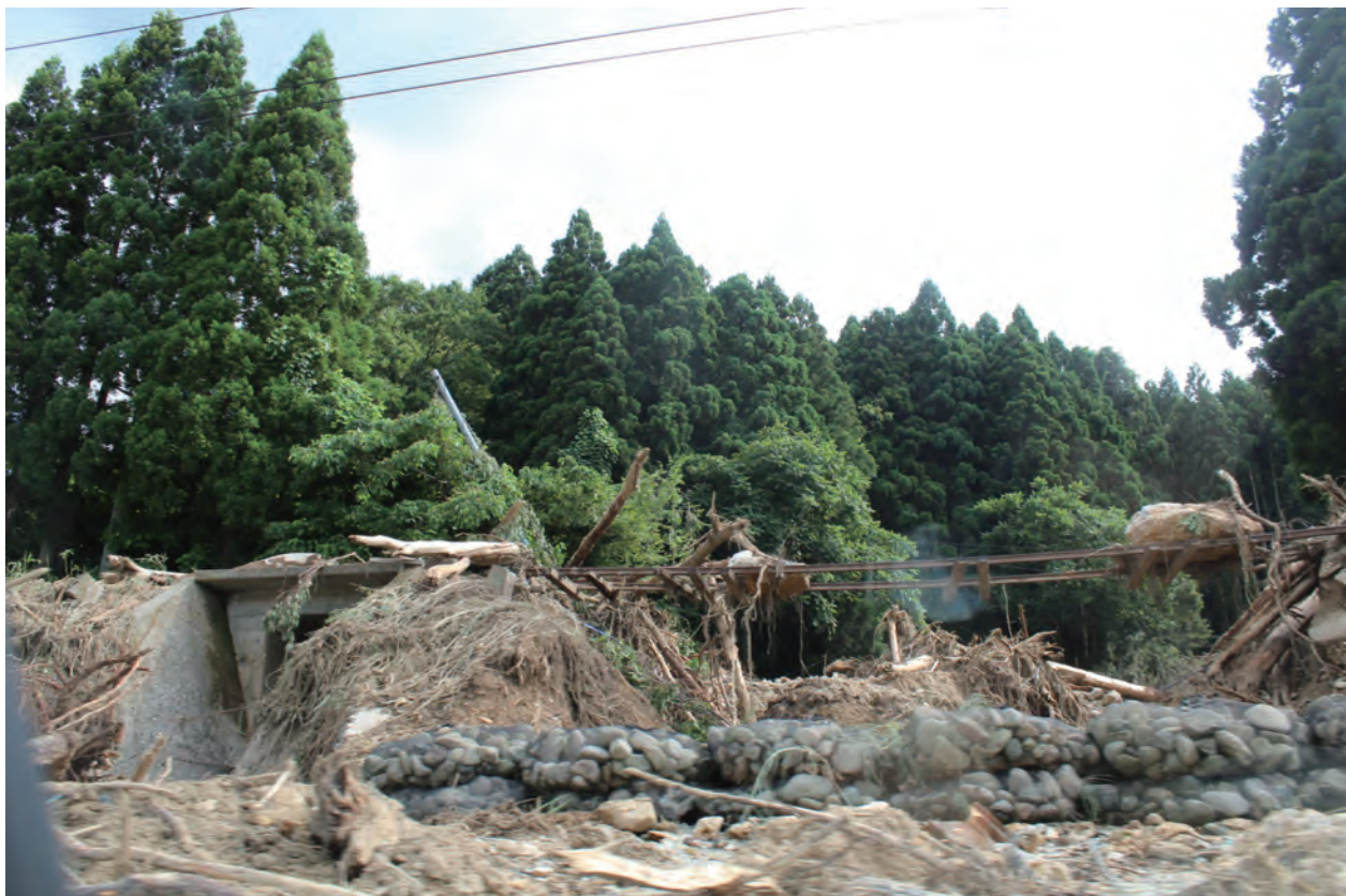
新潟県村上市 - 路盤が流出し、むき出しとなった JR 米坂線のレール (2022 年 8 月撮影)
