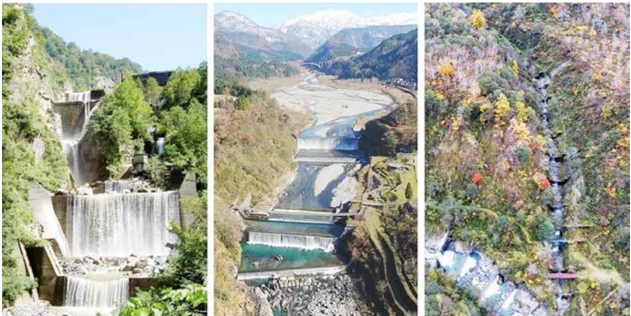
写真9：常願寺川砂防施設〔国指定重要文化財／左から白岩堰堤・本宮堰堤・泥谷堰堤群〕
