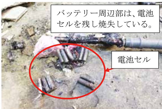
【写真4 ポールソーの焼損状況】
