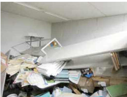
写真7 超高層建築の高層階で固定していない本棚の転倒（2011年東日本大震災）
