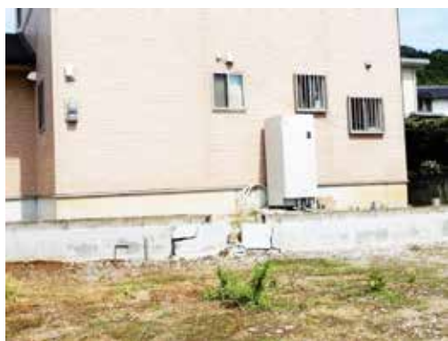
写真9 活断層直上でも無被害であった2000年基準の木造住宅(2016年熊本地震)
