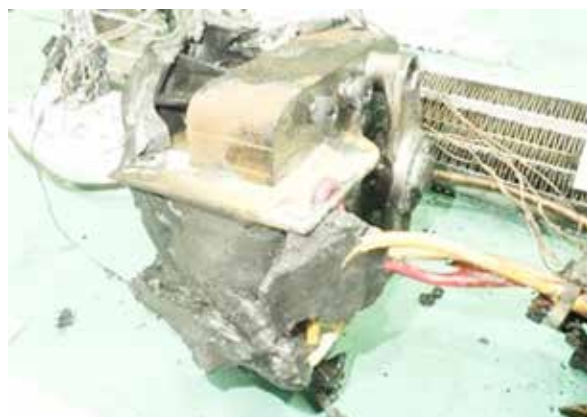
【写真16 焼損品：ファンモーター】
