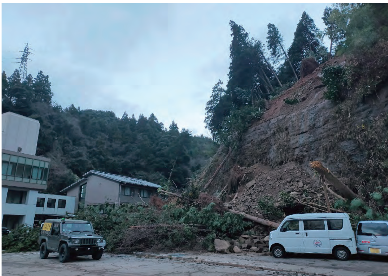
石川県穴水町（役場横の崖）：地震により発生したがけ崩れ（2024年1月5日撮影）
