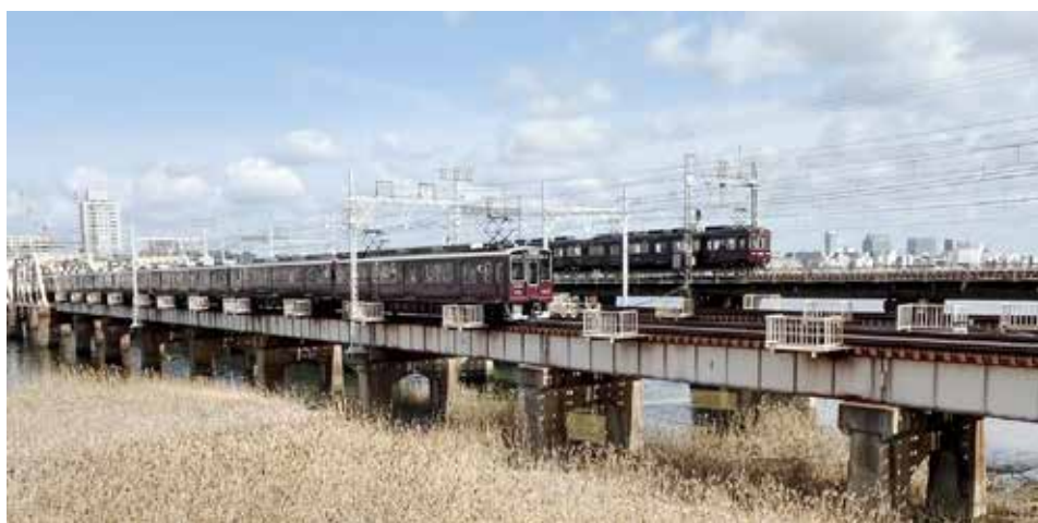
写真2 淀川に架かる鉄道橋（手前の阪急電鉄神戸線、宝塚線鉄橋は100年確率洪水対応、背後の京都線鉄橋は200年確率洪水対応で、前者より約1.5m 高くなっている。）（筆者撮影）
