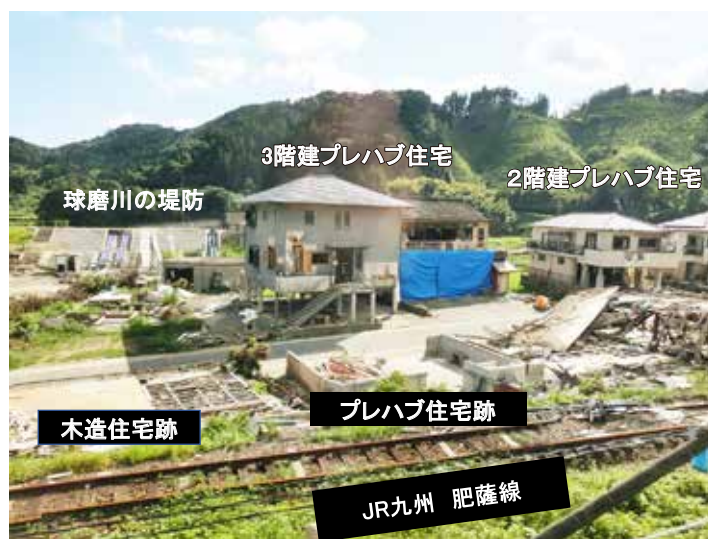
写真3 2020年球磨川が越流氾濫し、堤内地では2階の天井まで水没した。浸水深が長期にわたって深くなり、鉄道橋梁の複数流失や300kmに及ぶ道床被害が発生した。写真の人吉市右岸地区ではタイムラインの発動は少し遅れたが死者はゼロだった（筆者撮影）。
