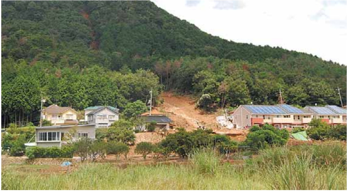
広島市安佐北区可部東地区の土砂災害の様子 (平成26年8月21日撮影)
