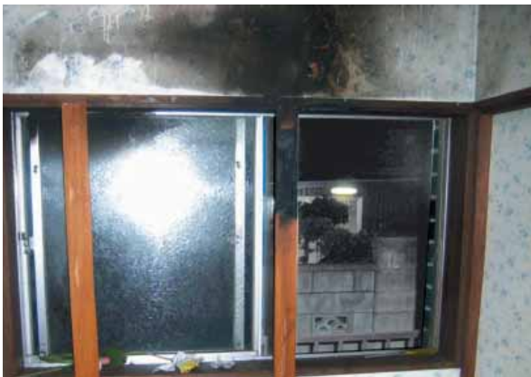
写真 洗面化粧台が設置されていた腰高窓
