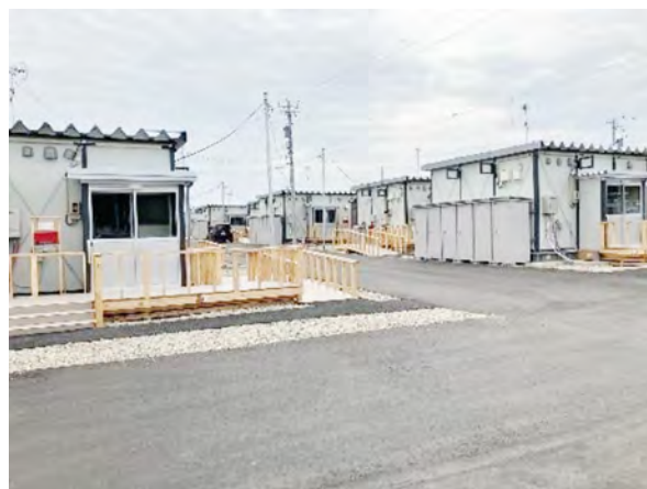
写真2 仮設住宅の様子
