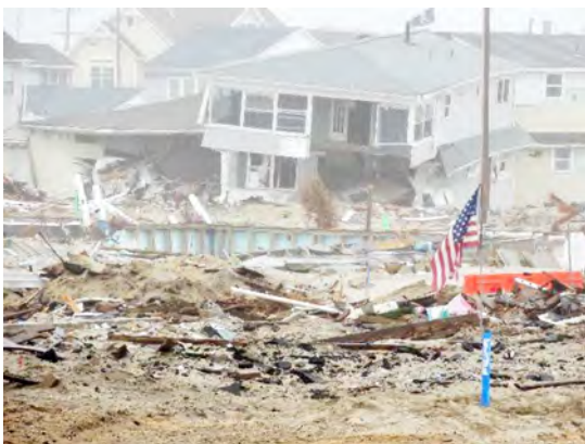
図-1 トムズリバー市シーサイドビーチの被災状況
