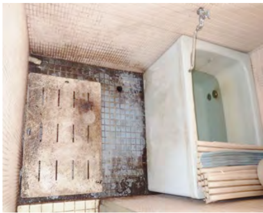
写真3 浴室の状況③
