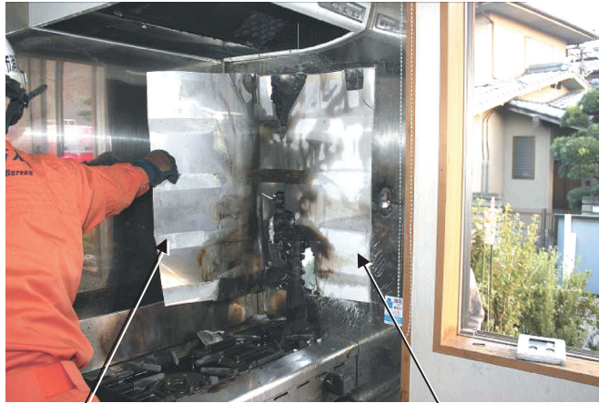
ステンレス板の裏面 石膏ボード 壁内の状況（ステンレス板を切断）
