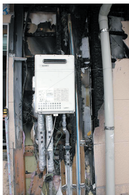
壁内の状況（外壁材を除去）
