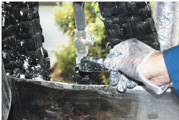
壁内から採取された木ずりの破片（出火箇所直下）
