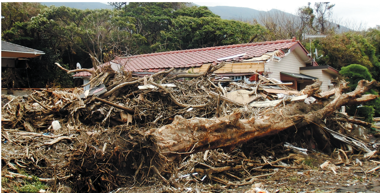
大島町の土砂災害の状況 (平成25年10月23日撮影)
