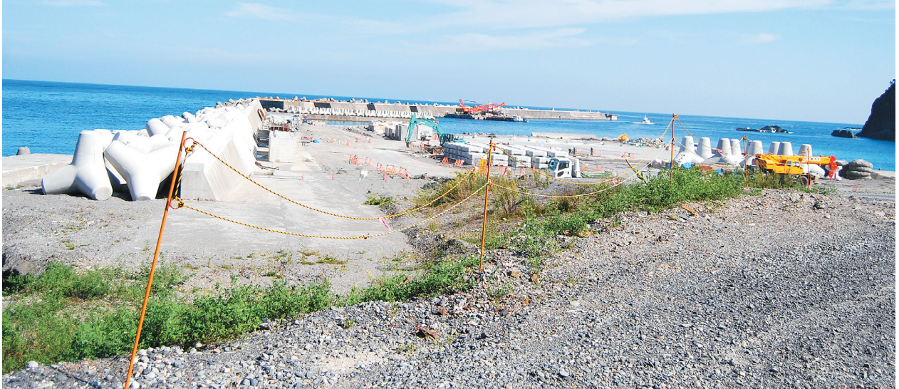
岩手県岩泉町小本港復旧工事 (2013年9月20日撮影)
