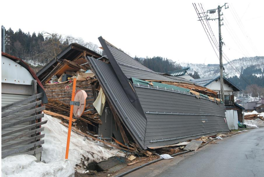
写真1 2階部分が押しつぶされ、屋根が道路側に崩落した公民館
