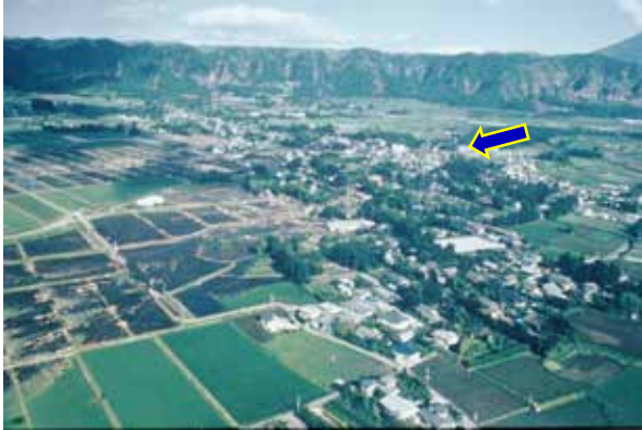
図1 国道橋が流木により閉塞されたために土石流が周辺に氾濫し人命、人家等に甚大な被害を与えた(1990年7月、熊本県一の宮町古恵川)
