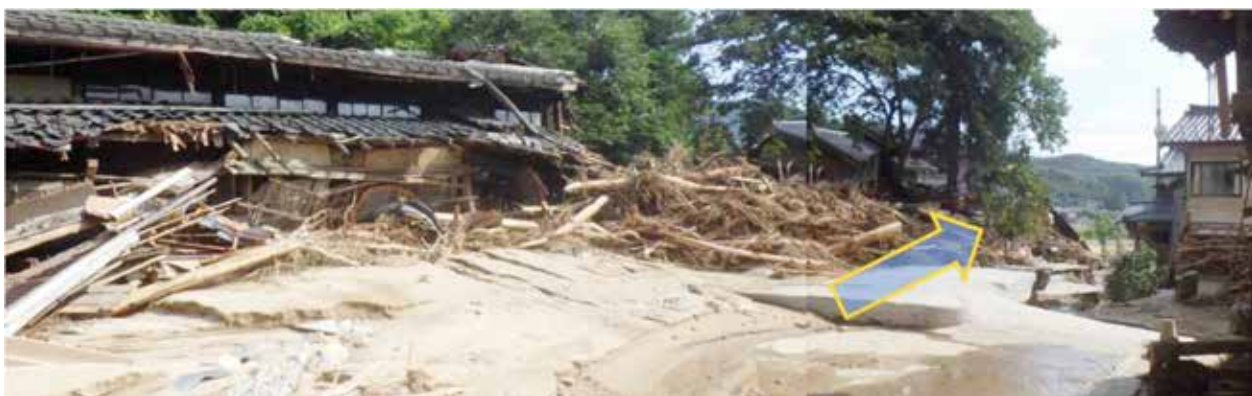
図7 流木による橋梁閉塞により氾濫した洪水による家屋被害(2022年8月豪雨による村上市小岩内大沢川)
