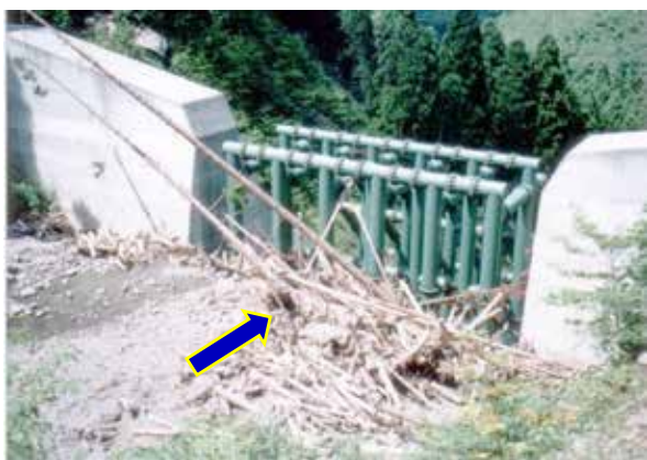
図15 鋼製透過型砂防堰堤による流木の捕捉例、福岡県田主丸町冷水川
