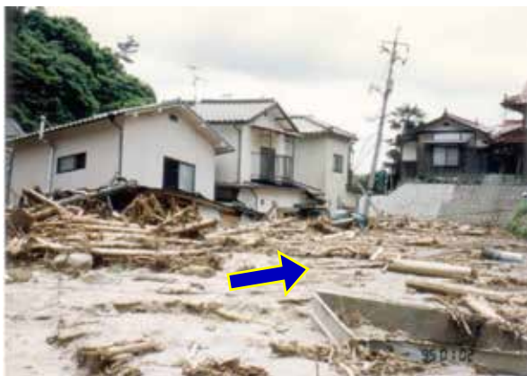
図2 溪流に架かる橋梁の流木による閉塞に伴う土石流の氾濫と人家の被害(1999年6月の広島災害における荒谷川)
