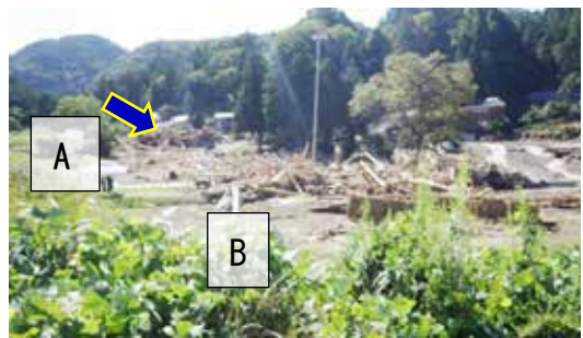
図9 塚田川のA, B地区における流木による橋梁の閉塞に伴う土砂・洪水・流木の氾濫状況（2024年9月）
