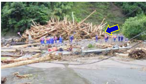
図5 流木により閉塞された橋梁(2017年7月九州北部豪雨、福岡県東峰村、大肥川支川宝珠山川)
