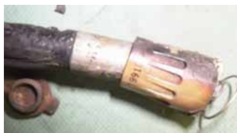
写真19 ガスコード破損部分
