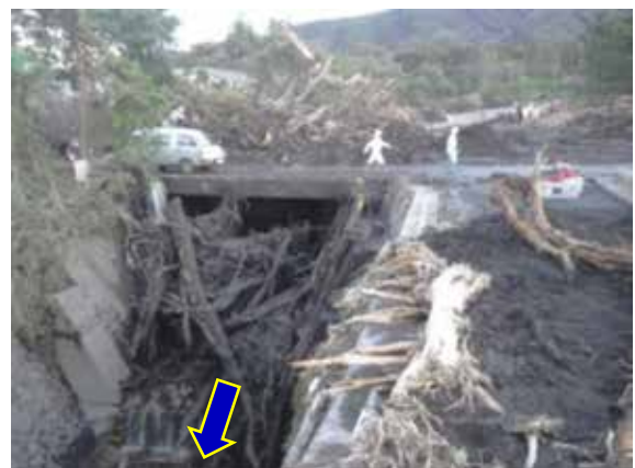
図4 伊豆大島大金沢における流木による橋梁の閉塞と土石流の氾濫(2013年10月台風26号による災害)
