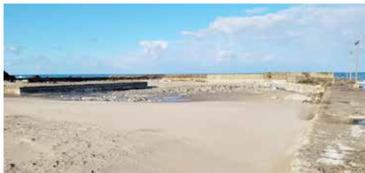
写真2 隆起によって干出した漁港（輪島市黒島漁港：2024年2月16日 青木撮影）
