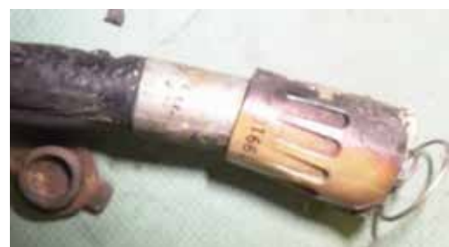
写真19 ガスコード破損部分
