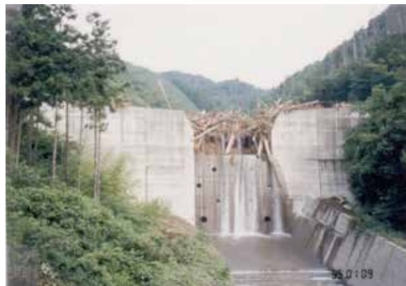
図16 部分透過型砂防堰堤による流木の捕捉例、広島災害（1999年6月）荒谷川
