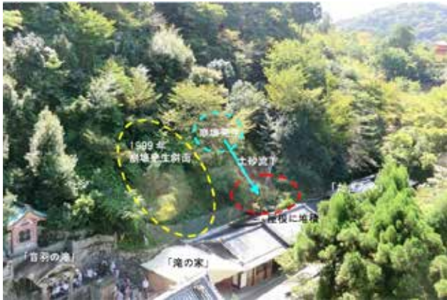
図-1 2013年の8月における音羽の滝横の斜面崩壊の様子 (発生から1日後)
