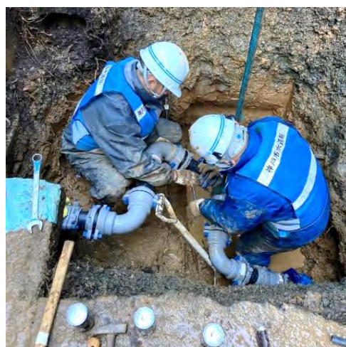
写真6 漏水箇所の修理（穴水町内）
