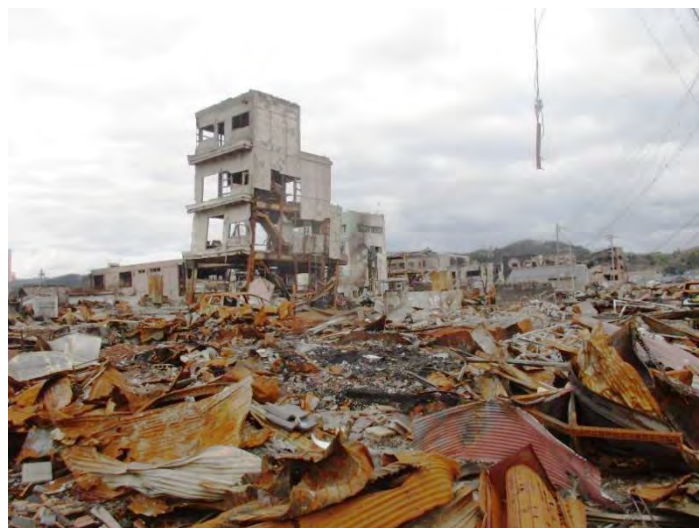
写真3 朝市通りの火災跡（輪島市）
