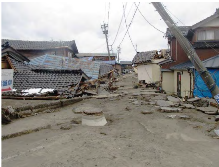
写真1 家屋倒壊の様子（珠洲市宝立町）
