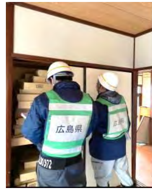
写真2 住家被害認定のための 2次調査
