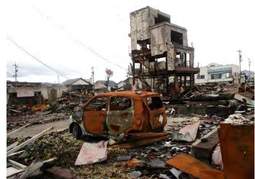
朝市の火災現場跡
