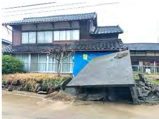
家屋被害玄関先の様子
