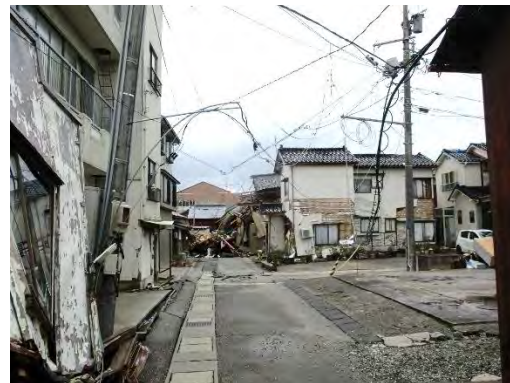
倒壊した家屋による道路閉塞
