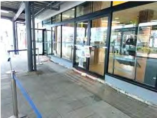
七尾駅舎の被害(液状化による段差)
